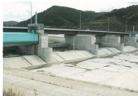
斐伊川放水路分流堰
